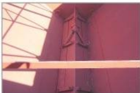
+| RIENDAS INTERIORES DE SUSTENTACION Enganches internos para elevación y quilofina de regulación.
